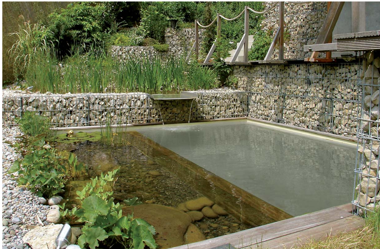
Gut durchströmte Kiesbereiche bleiben sauber, weil Grobschmutz durch den Schwimmteichfilter aus dem Teichsystem entsorgt wird.
