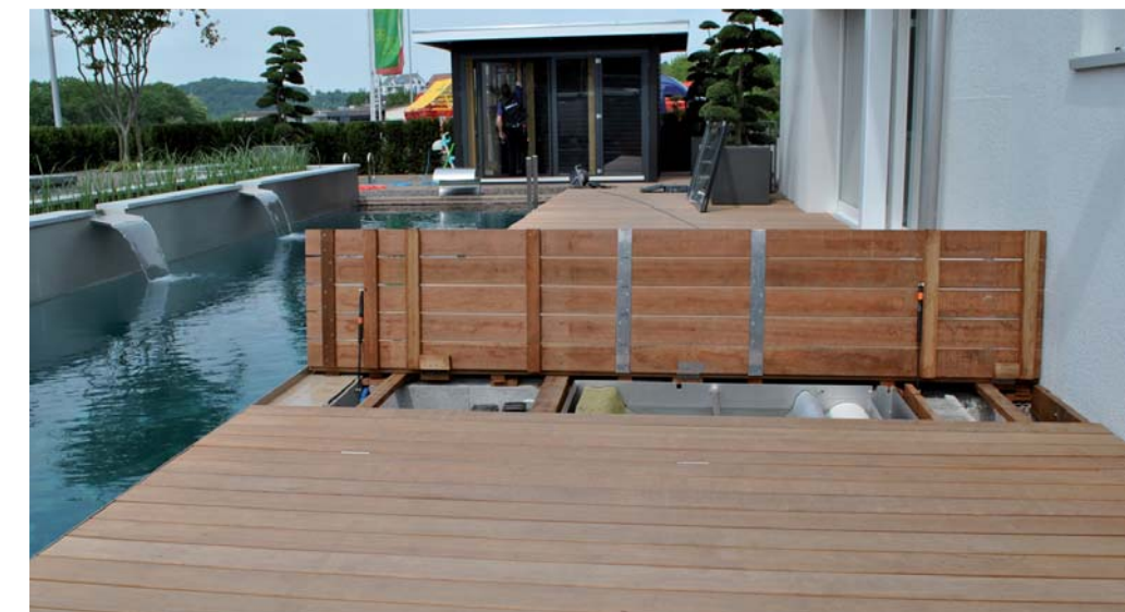
Smartpond Schwimmteichfilter in Aktion. Obwohl der Schwimmteich einen sehr sauberen Eindruck macht, wird durch den Vliesfilter permanent Schmutz aus dem System filtriert.
