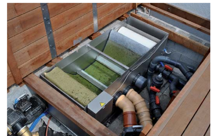
Smartpond Schwimmteichfilter in Aktion. Obwohl der Schwimmteich einen sehr sauberen Eindruck macht, wird durch den Vliesfilter permanent Schmutz aus dem System filtriert.
